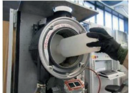
6. Isı eşanjörünün bobinlerini suyla yıkayın. 7. Yoğuşma drenajını kontrol edin. 8. Sifonu temizleyin.
