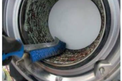
2. Spiralleri metal olmayan kıllı bir fırça ile temizleyin.
