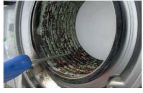
4. Isı eşanjörü spiralleri arasındaki boşlukları yüksek basınç altında üfleyin.
